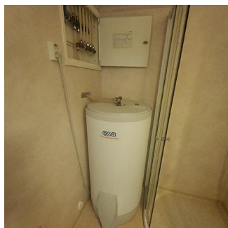
Varmtvannsbereder - Varmtvannsbereder og fordelerskap plassert på bad
