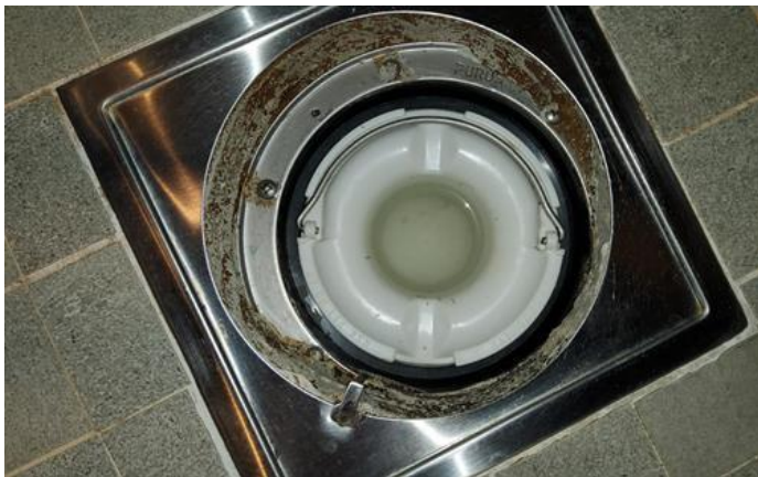
Avløpsrør (ink. sluk) - [Sluk bad ved entre.]
