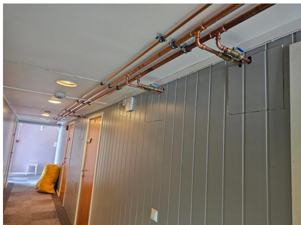
Nye rør lagt opp under himlingen.
