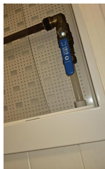
Innvendig stoppekran - Stoppekran.
