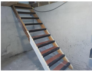
Rekkverk og håndløper - Trapp til kjeller.
