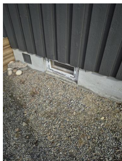
Vinduer og omramming - Eksempel på kjellervinduer.
