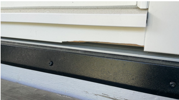
Skade i balkongdør i stue
