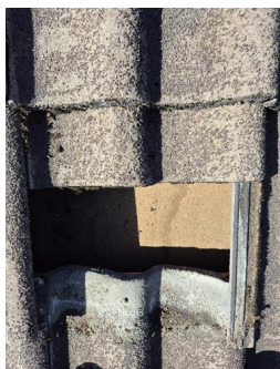
Undertak (inkluderer sløyfer, lekter og innfestninger) - Undertak opprinnelig del av boligen.
