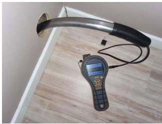
Utført kontroll i tilliggende konstruksjon - Fuktmåling i vegg.
