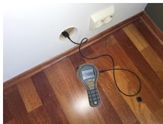
Utført kontroll i tiliggende konstruksjon - Fuktmåling i vegg.
