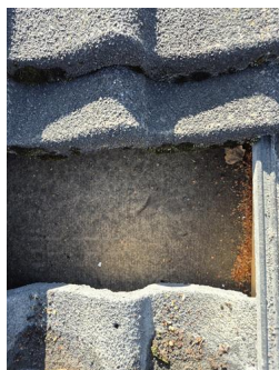
Undertak (inkluderer sløyfer, lekter og innfestninger) - Undertak tilbygget del av boligen.
