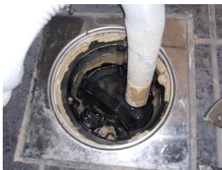
Avløp (inkl. sluk) - Sluk under dusjkabinett.
