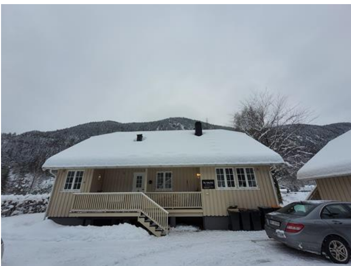
Yttertak - [Eksempel på snødekket yttertak på boligen. ]
