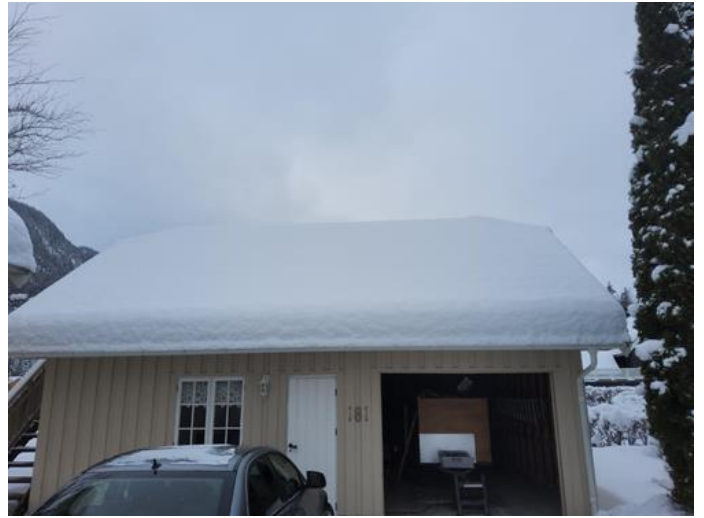
Frittstående byggverk - [Snødekt tak på garasje.]
