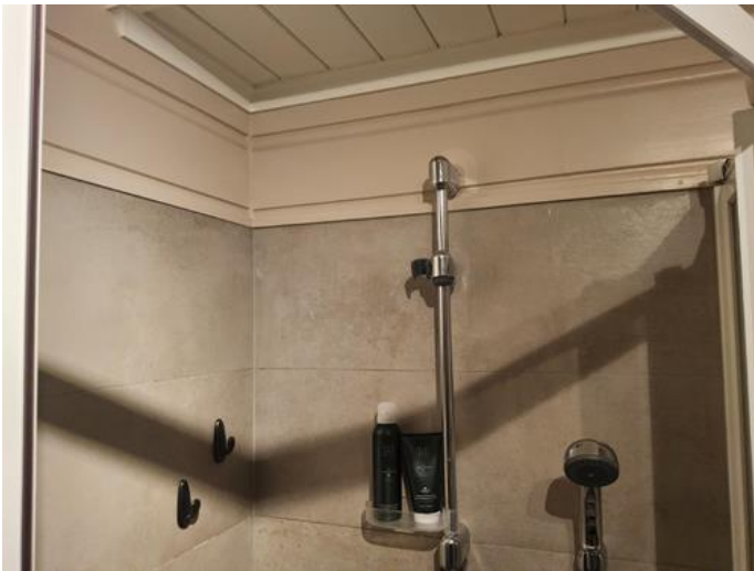
Membran, tettesjikt og overgang til sluk. - [Avsluttet membran høyde i dusj på bad i kjeller.]
