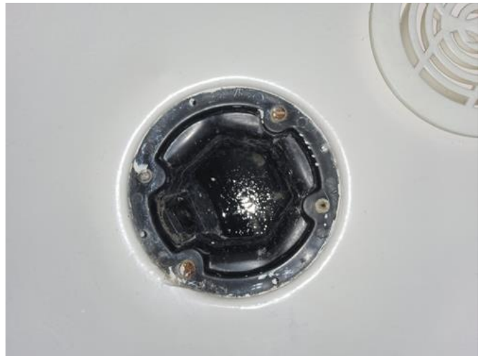
Avløpsrør (ink. sluk) - [Sluk på vaskerom.]
