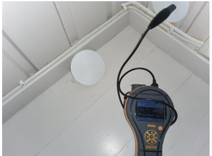
Våtrom - [Fuktmåling badevegg bad 2.etasje ]
