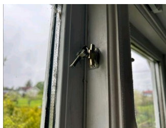
Vinduer og omramming - -
