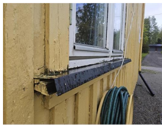
Vinduer og omramming - -
