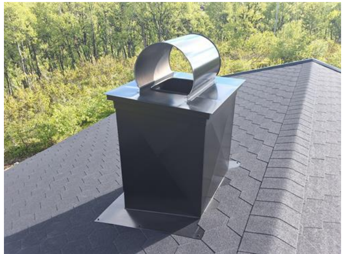
Utvendig - [Blikkbeslått pipe]
