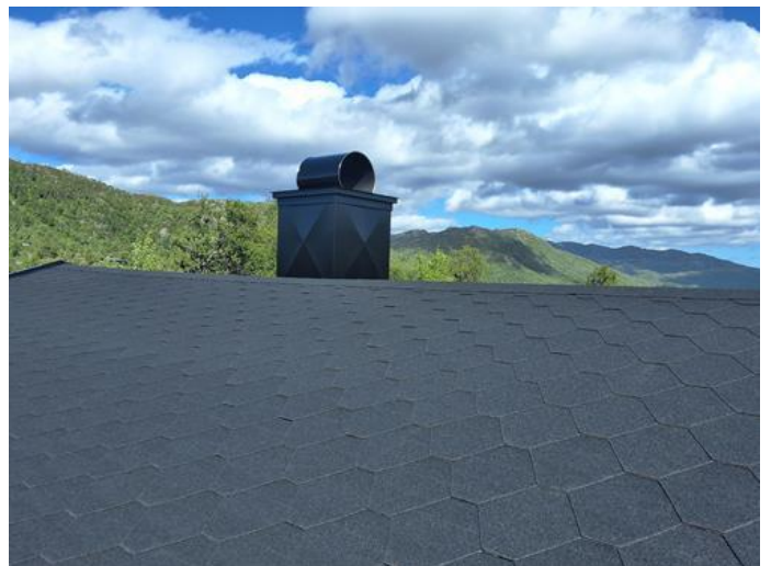
Utvendig - [Nedbøy i takflate]
