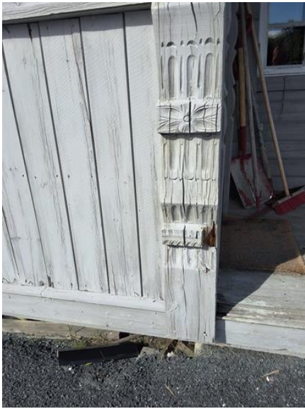
Utvendig - [Søyle ved inngang]
