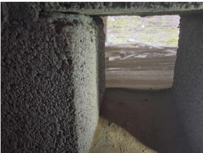
Innvendig - [Lufteluke i lite rom/kjeller]
