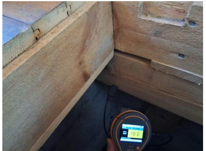
Innvendig - [Fuktmålinger i bjelkeaget]
