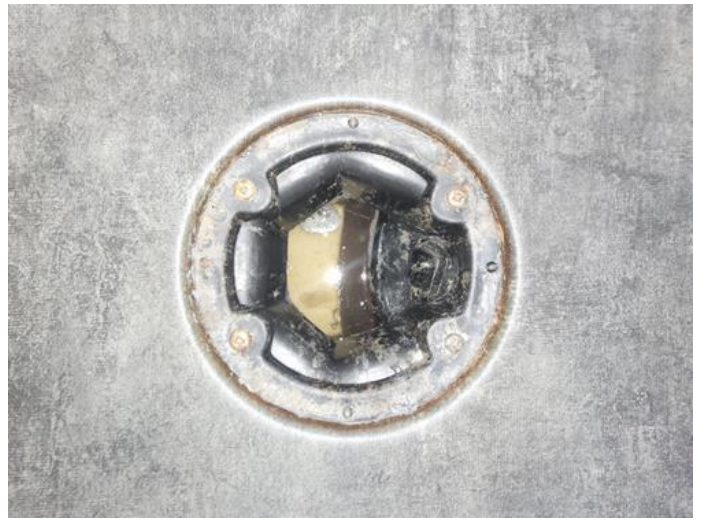
Avløpsrør (ink. sluk) - [Sluk på bad.]
