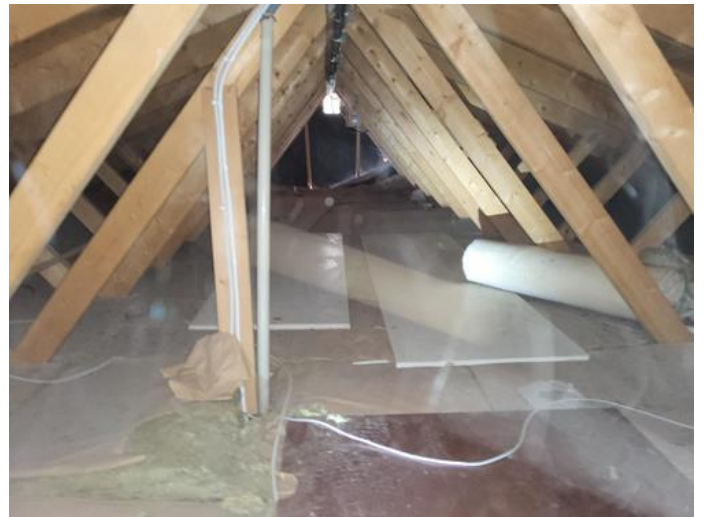
Loft - uinnredet / råloft - [Loft.]
