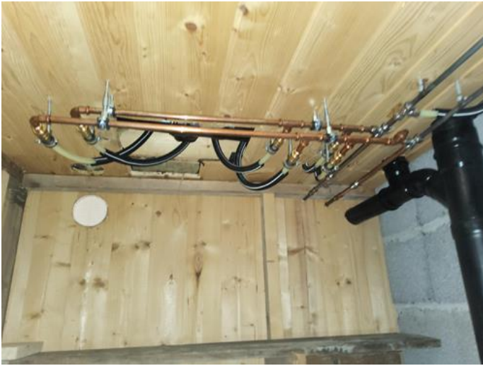
Vannrør (Sjekkpunkter utover det som er inkludert i andre rom) - [Fordelerstammer for rør-i-rør.]
