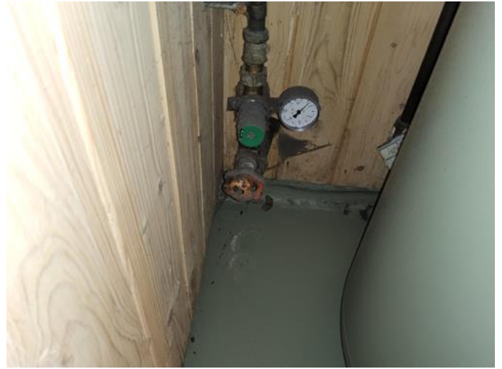
Hovedstoppekran - [Innvendig stoppekran.]
