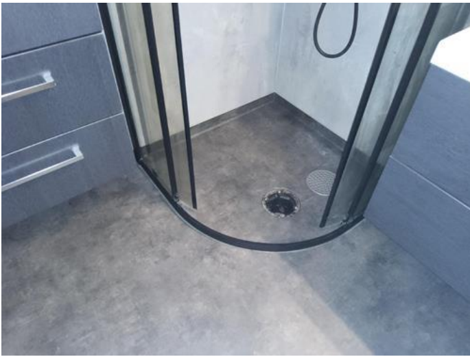
Slukets plassering i forhold til at vann utenfor dusjsonen kan nå det - [Slukets plassering på bad.]
