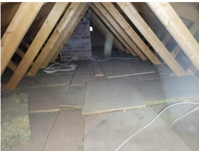
Loft - uinnredet / råloft - [Loft.]
