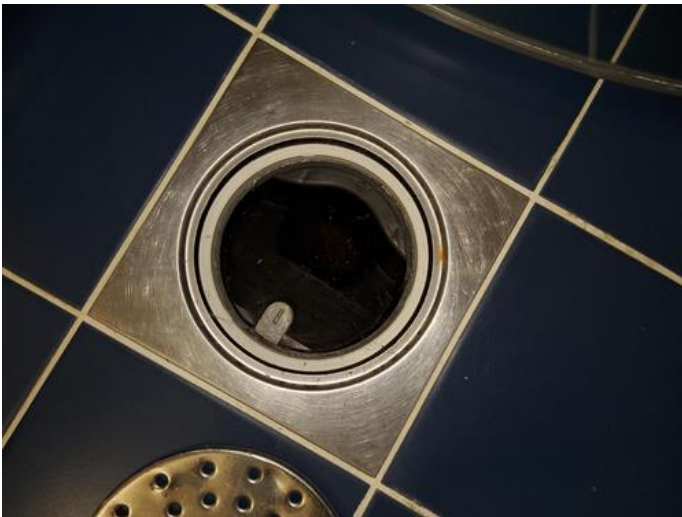
Våtrom - [Sluk bad underetasje]
