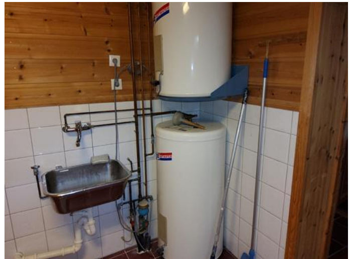
Tekniske anlegg, VVS anlegg (Sjekkpunkter utover det som er inkludert i andre rom) - [Teknisk anlegg]
