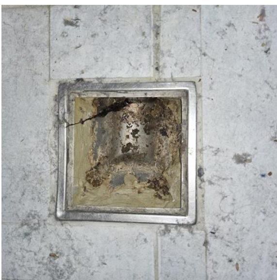
Våtrom - [Sluk under dusjkabinett bad kjeller ]
