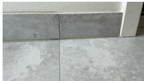
Sprekk i fuger ved ytterdør.
