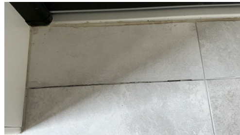
Sprekk i fuger ved ytterdør.
