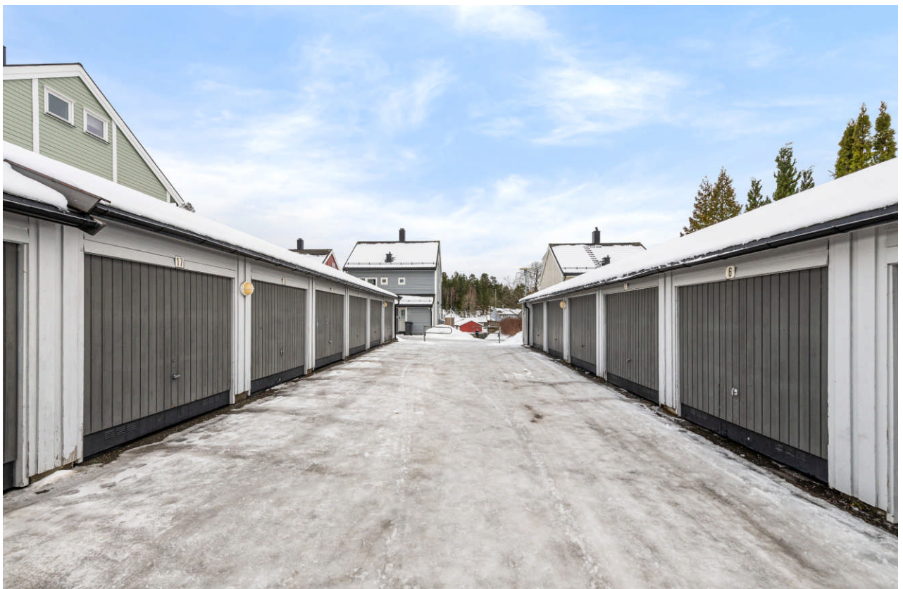
Boligen disponerer 1. plass i felles rekke med el-bil lader. Ved inngangen til boligen er det opparbeidet biloppstillingsplass til 1 bil.
