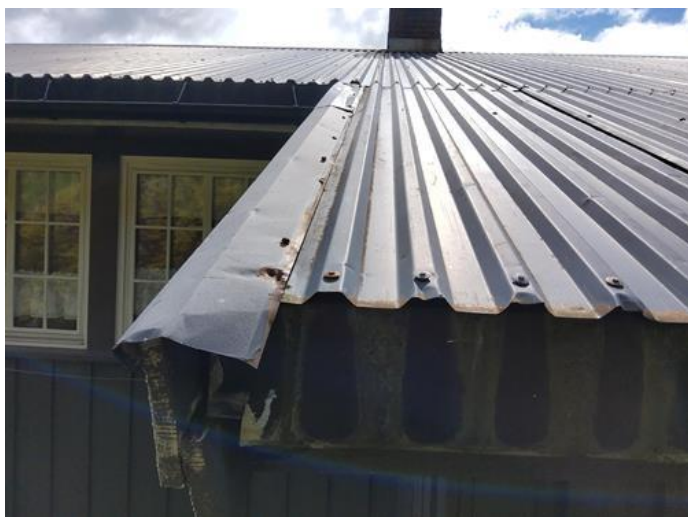
Beskrivelse - [Slitasje på takteking/israft]
