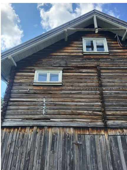
Yttervegger inkl. fasader og konstruksjon - [Sidebygning]
