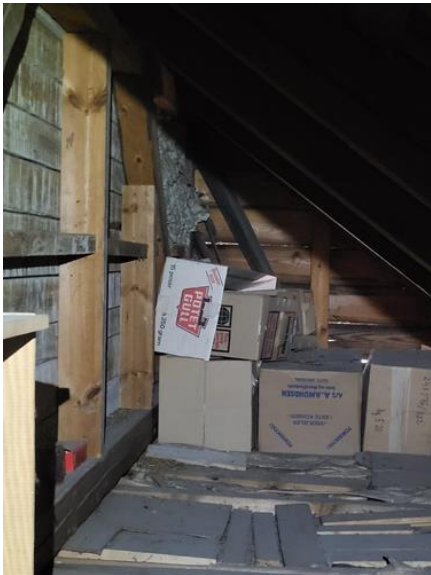
Loft - uinnredet / råloft - [Kott sidebygning. ]
