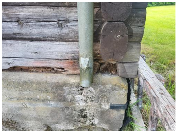
Yttervegger inkl. fasader og konstruksjon - [Sidebygning]
