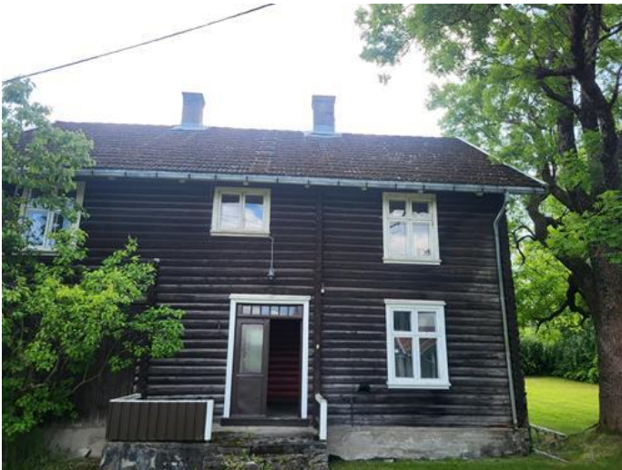
Utvendig - [Yttertak sidebygning]
