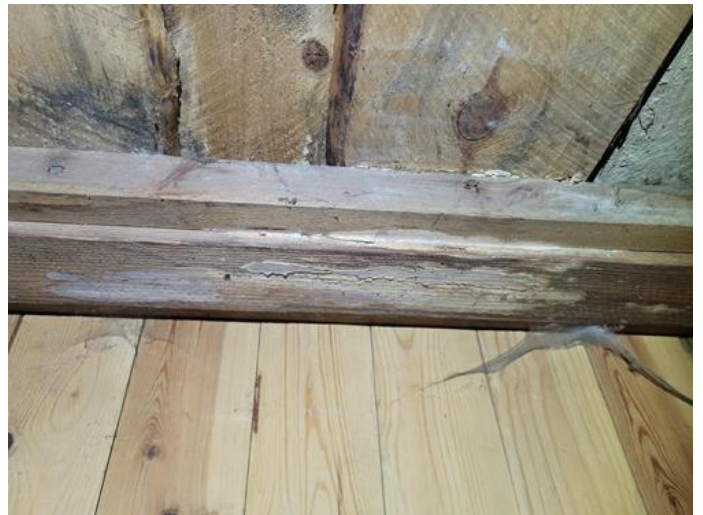
Rom under terreng (kjeller, underetasje, sokkeletasje) - [Sopp/muggdannelse i bjelkelag hovedhus. ]
