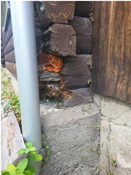
Yttervegger inkl. fasader og konstruksjon - [Hovedhus]
