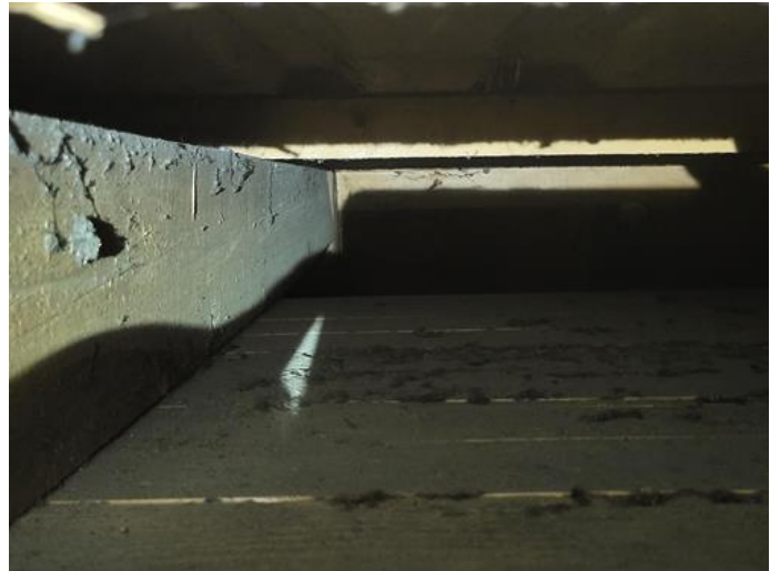
Loft - uinnredet / råloft - [Kott sidebygning. ]
