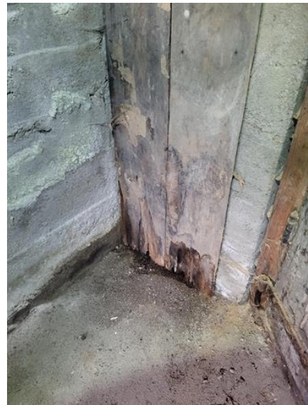
Rom under terreng (kjeller, underetasje, sokkeletasje) - [Fuktmerker i sidebygning]
