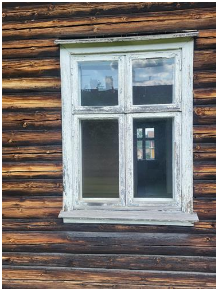
Yttervegger inkl. fasader og konstruksjon - [Sidebygning]
