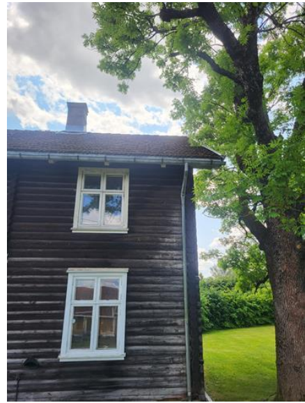
Utvendig - [Yttertak sidebygning]
