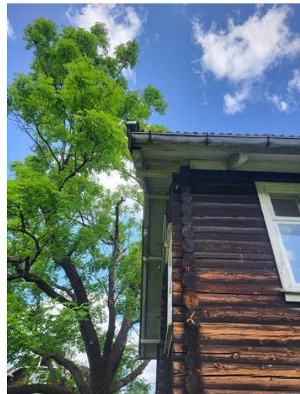
Utvendig - [Yttertak sidebygning]
