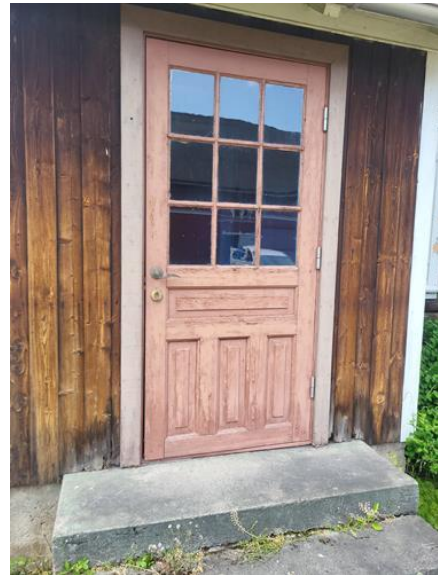
Yttervegger inkl. fasader og konstruksjon - [Hovedhus]
