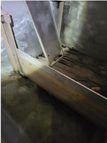
Rom under terreng (kjeller, underetasje, sokkeletasje) - [Fuktskader, råte på treverk hovedhus]
