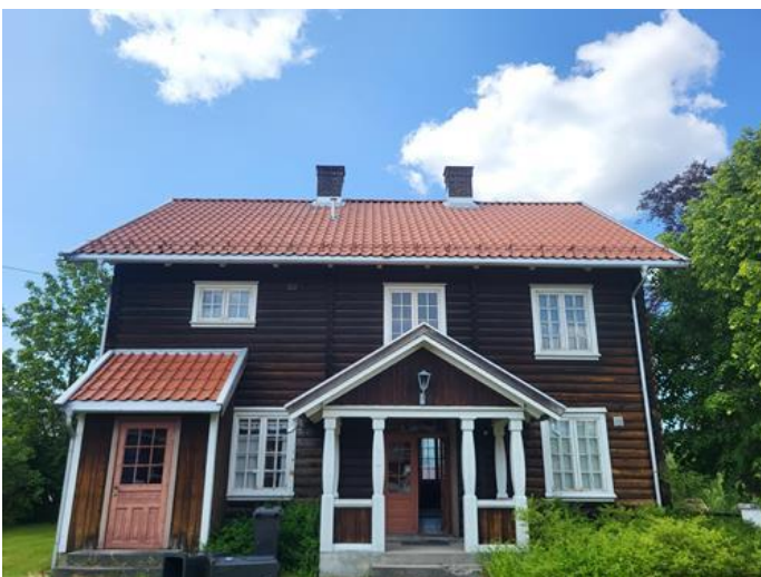
Utvendig - [Yttertak hovedbygning]
