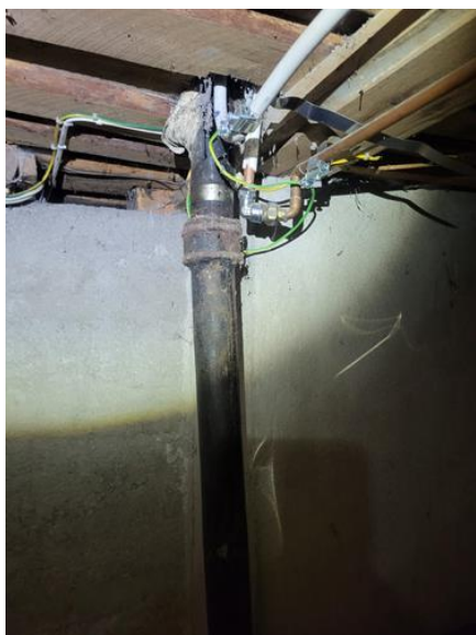
Tekniske anlegg, VVS anlegg (Sjekkpunkter utover det som er inkludert i andre rom) - [Eldre avløpsrør av metall Tyrivegen 13]
