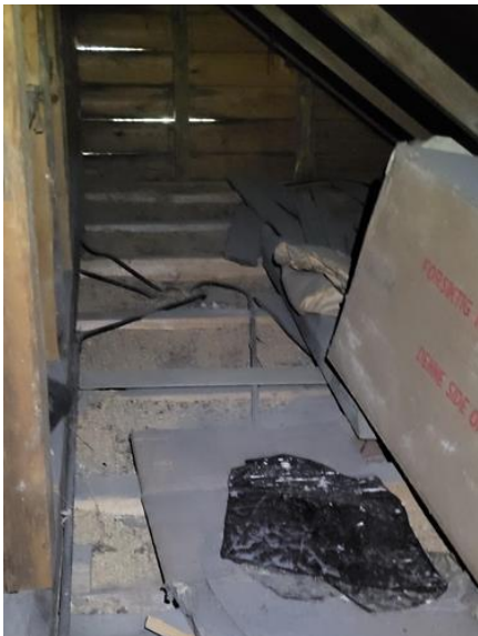
Loft - uinnredet / råloft - [Kott sidebygning. ]
