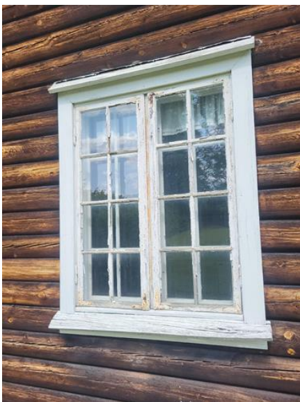
Yttervegger inkl. fasader og konstruksjon - [Hovedhus]
