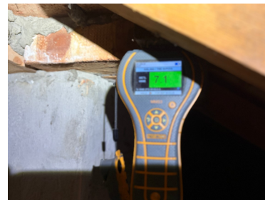
Det ga ikke indikasjon på fukt på befæringsdato
