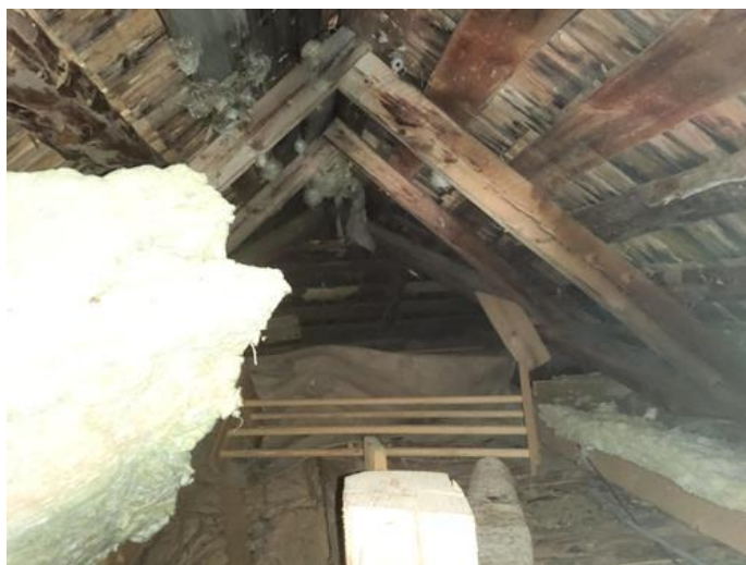
Loft - uinnredet / råloft - [Kryploft hovedhus.]
