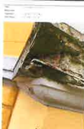
Store skader ved karnapp, fare for nedfall av puss
