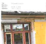
Store skader ved karnapp, fare for nedfall av puss
