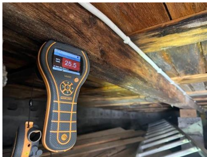
Helhetsvurdering - [Fuktmåling i krypekjeller]
