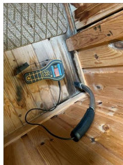
Overflate gulv - Fuktmåling i entre
