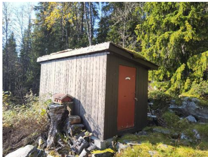
Utvendig - [Frittliggende bod]
