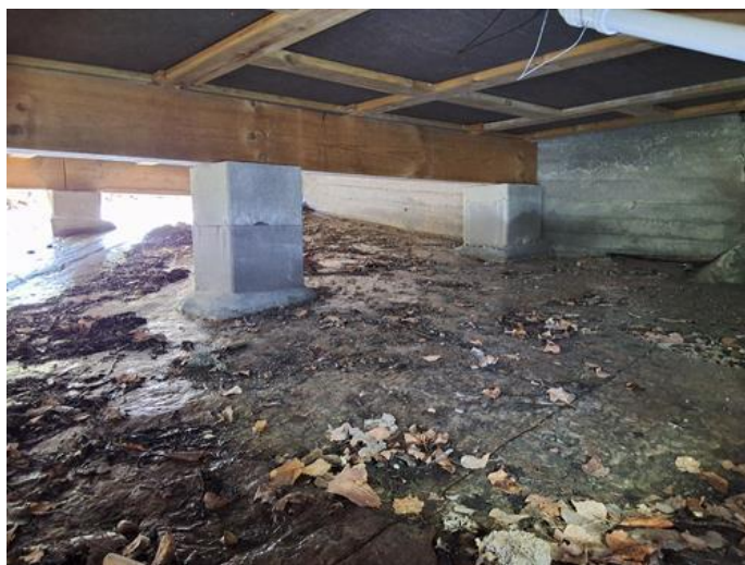
Utvendig - [Fundamenter under tilbygg fra 2012]
