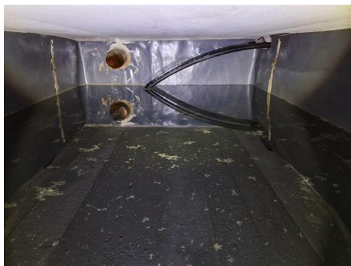
Innvendig - [Vannmagasin/sisterne under innvendig bod. Vannet blir tappet ut på høsten. ]
