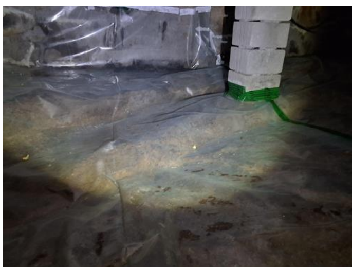
Krypekjeller - [Plast på grunn i krypkjeller]
