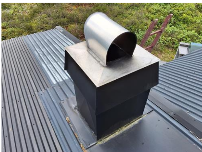
Utvendig - [Pipe over tak]
