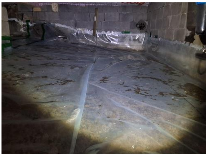
Krypekjeller - [Plast på grunn i krypkjeller]
