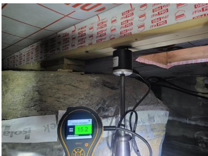
Krypekjeller - [Fuktmålinger i krypkjeller, verdier under 16 vektprosent.]
