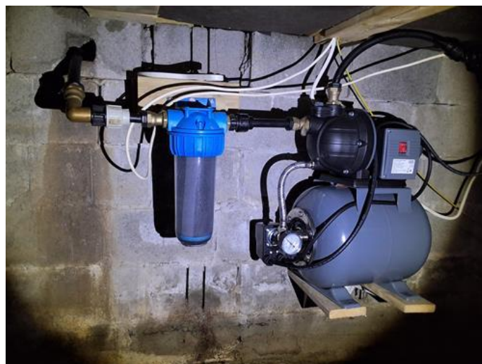
Tekniske anlegg, VVS anlegg (Sjekkpunkter utover det som er inkludert i andre rom) - [Vannpumpe og røropplegg i krypkjeller]
