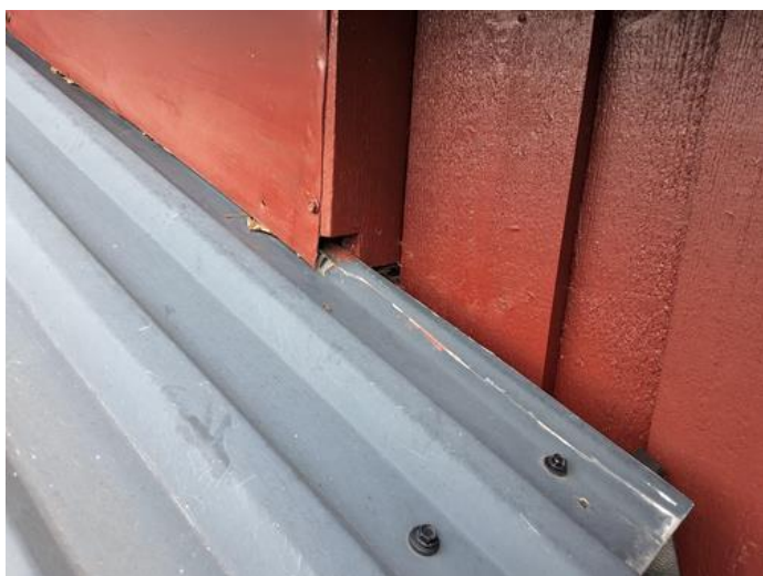
Utvendig - [Overgang tak vegg gammel/ny del]
