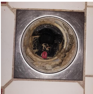
Vannnett sjikt / membran i gulv og vegger - Sluk bad i 1.etasje.
