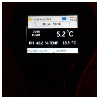
Utført kontroll i tiliggende konstruksjon - IMG_20260603_115041
