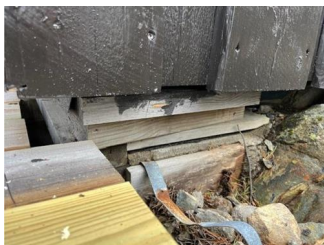
Søyler og pilarer - Eksempel på provisorisk understøttelse
