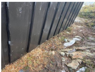
Terrengfall fra grunnmur - Fall mot grunnmur
