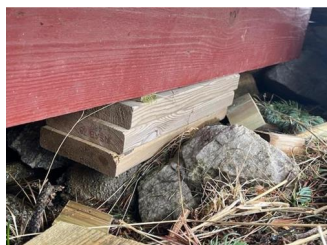
Søyler og pilarer - Eksempel på provisorisk understøttelse
