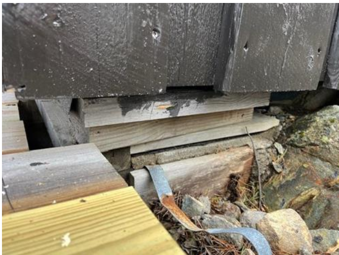
Beskrivelse - [Eksempel på provisorisk undertøttelse]
