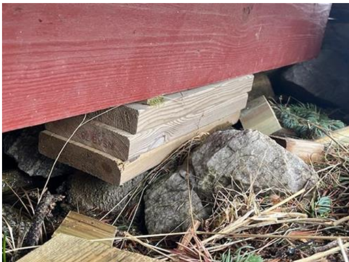
Beskrivelse - [Eksempel på provisorisk undertøttelse]
