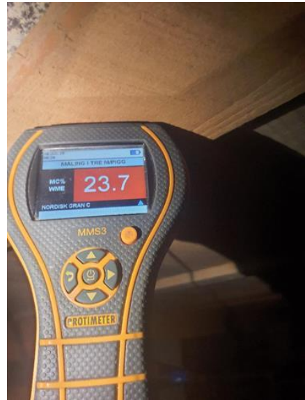
Krypekjeller - [Fuktmåling med pigg i etasjeskille krypkjeller.]
