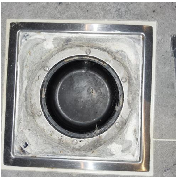
Avløpsrør (ink. sluk) - [Luk vaskerom ]
