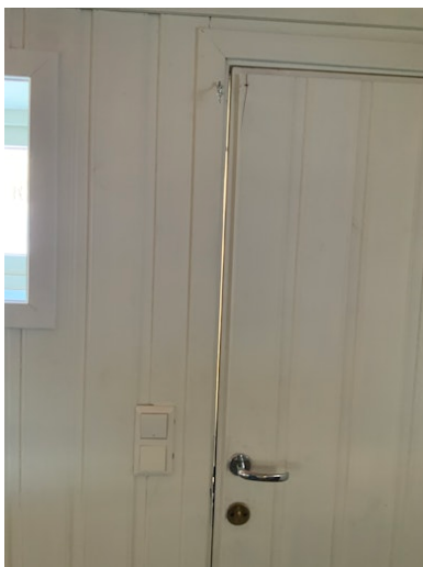
Luftspalt på ytterdør
