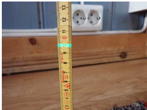
Måling i kjøkken
