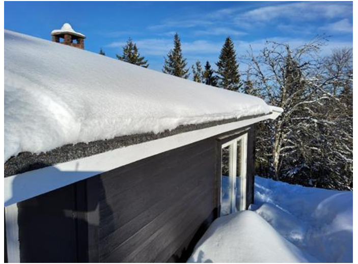
Utvendig - [Takutstikk mot sør]
