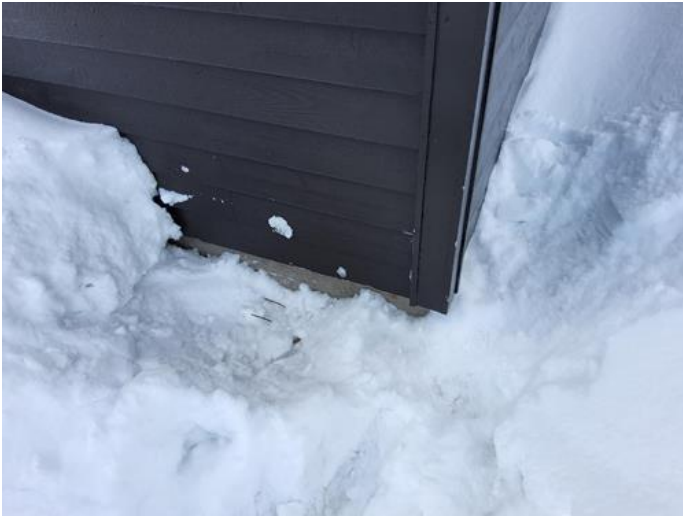
Yttervegger inkl. fasader og konstruksjon - [Vegg og grunnmur]
