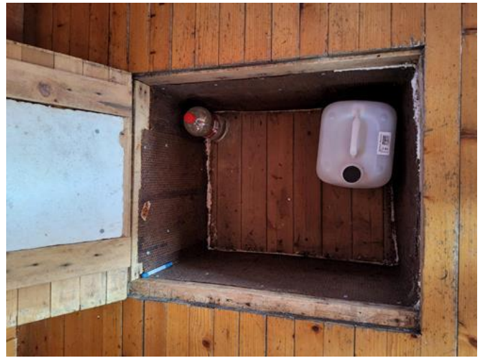
Kjøkken - [Luke med rom i kjøkkengulvet]
