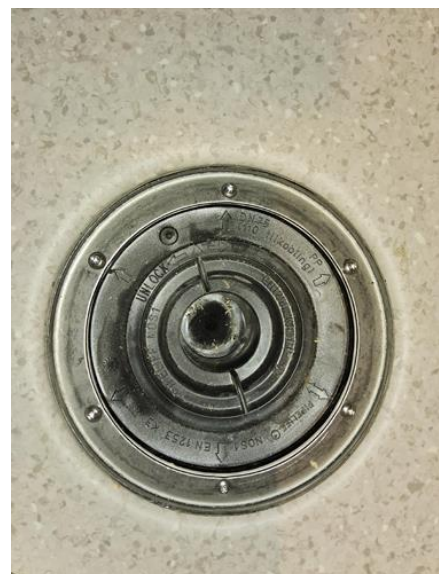
Avløpsrør (ink. sluk) - [Sluk, vaskemaskin hovedbad]
