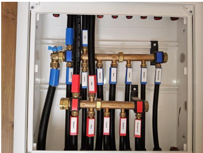
Tekniske anlegg, VVS anlegg (Sjekkpunkter utover det som er inkludert i andre rom) - [Samleskap for rør-i-rør systemet]
