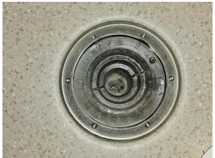
Avløpsrør (ink. sluk) - [Sluk hovedbad]
