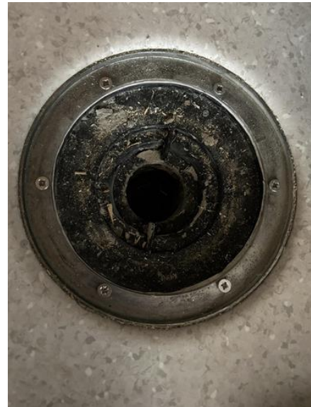
Annet - [Sluk, bod med utvendig adkomst]
