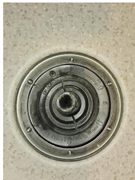
Avløpsrør (ink. sluk) - [Sluk, vaskemaskin hovedbad]
